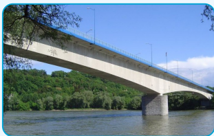
Spannbeton - Brücke über die Donau (Österreich)
