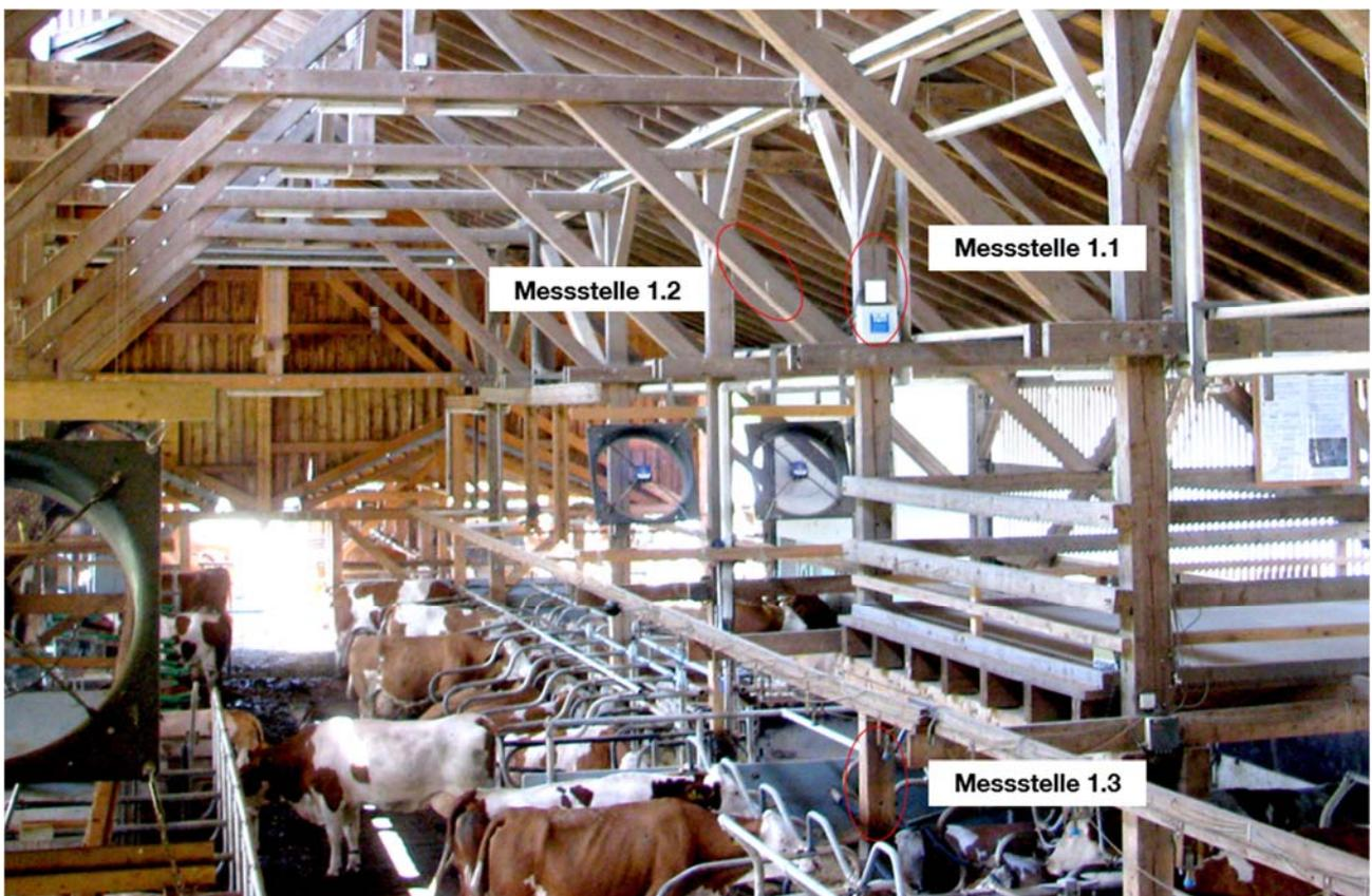
Abbildung 2: Anordnung der Messstellen des Messsystems 1
