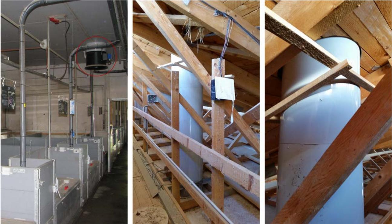
Abbildung 4-5: Abteil A des Objekts 06 mit Ferkelnestern und mechanischem Entlüftungssystem
