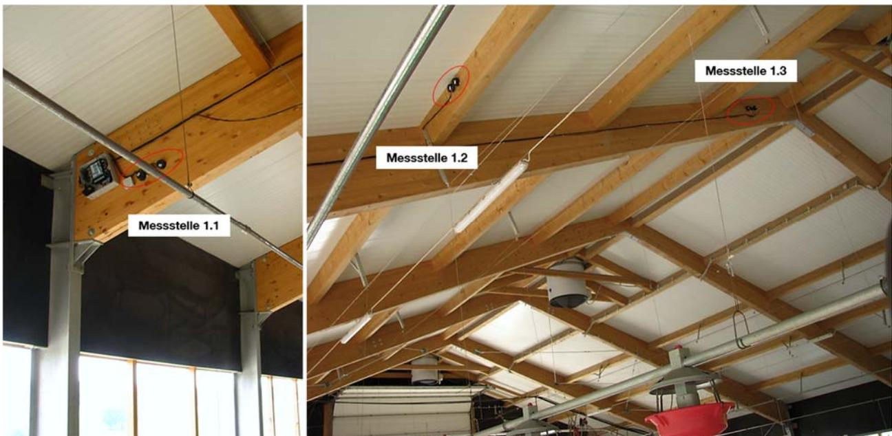
Abbildung 35: Anordnung der Messstellen des Messsystems 1
