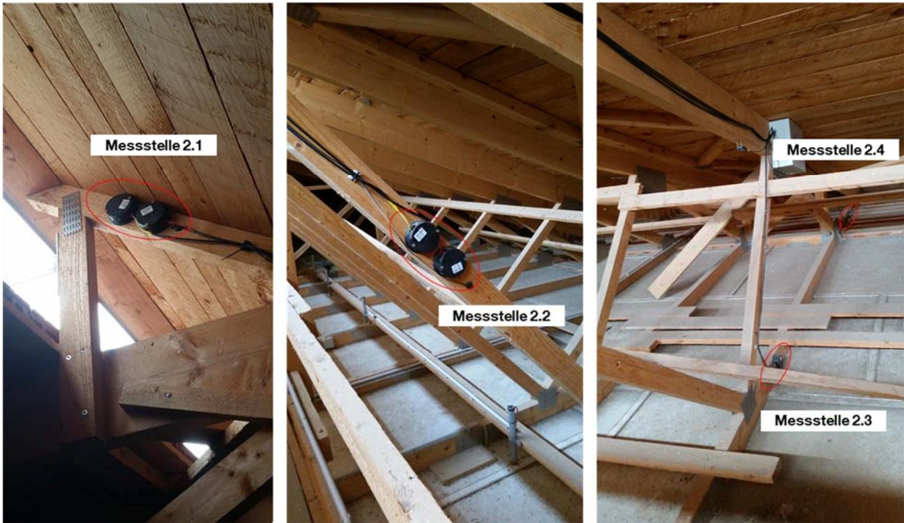
Abbildung 19: Anordnung der Messstellen des Messsystems 2 (Abteil A)
