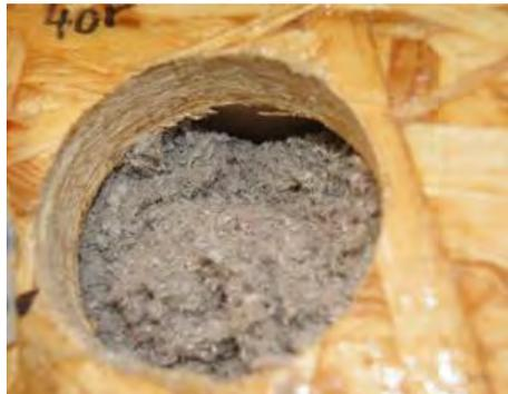
BILD 9-26 NACHSACKUNG DER DÄMMUNG UM CA. 10MM IN GEFACH 4, AUFGENOMMEN AM 18.04.2013
