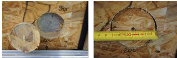
BILD 9-18 ZUSTAND DER SCHICHTGRENZE GEFACHDÄMMUNG / AUßENSEITIGE GEFACHBEPLANKUNG AN GEFACH 5 OBEN RECHTS AM 27.04.2012 UND ABMESSUNGEN DER ENTNAHMEPROBEN AUS DER GEFACHBEPLANKUNG
