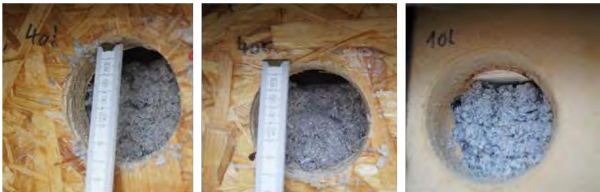
BILD 9-27 NACHSACKUNG IN DER DÄMMUNG VON GEFACH 1 UND GEFACH 4, AUFGENOMMEN AM 03.04.2015
