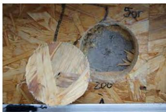
BILD 9-23 ZUSTAND DER SCHICHTGRENZE GEFACHDÄMMUNG / AUßENSEITIGE GEFACHBEPLANKUNG AN GEFACH 5 OBEN RECHTS AM 24.01.2013 UND ABMESSUNGEN DER ENTNAHMEPROBEN AUS DER GEFACHBEPLANKUNG
