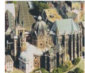
Rissmonitoring an historischer Bausubstanz, Beispiel: „Aachener Dom“
