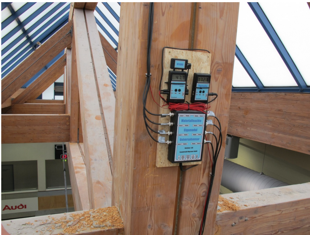
Abbildung D1-2: Ansicht Messstation
