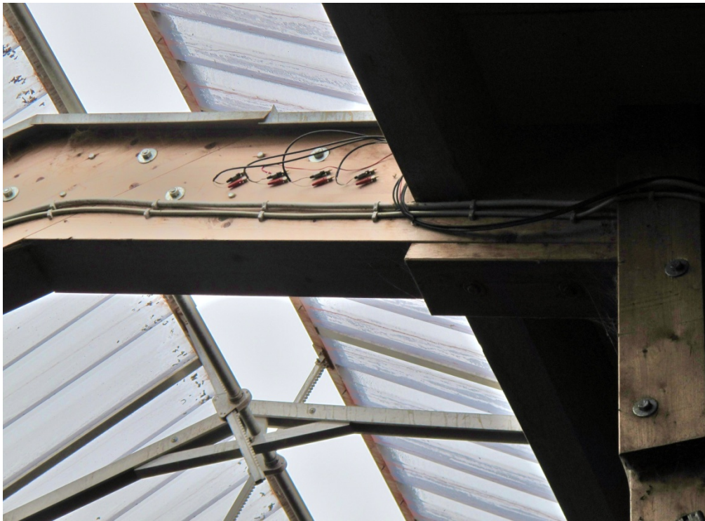
Abbildung F2-3: Ansicht Messstelle 1
