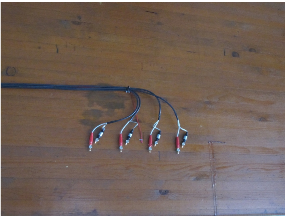
Abbildung B1-4: Ansicht Messstelle 2
