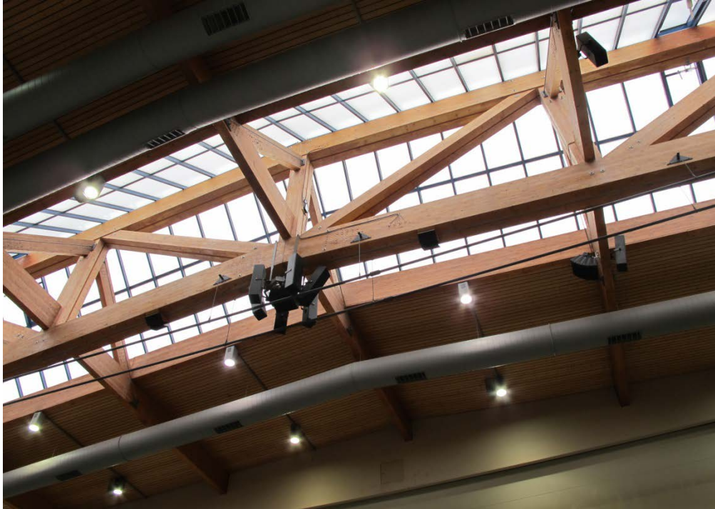
Abbildung D1-1: Ansicht Tragwerk
