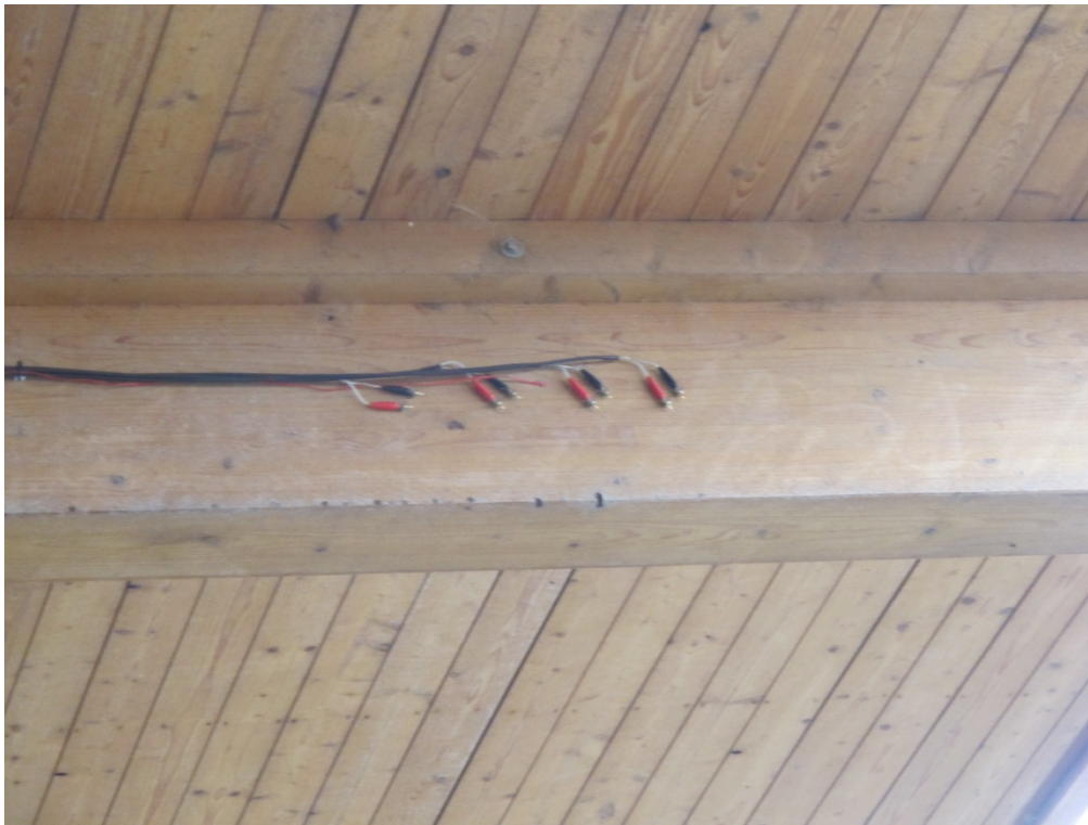
Abbildung F1-3: Ansicht Messstelle 1
