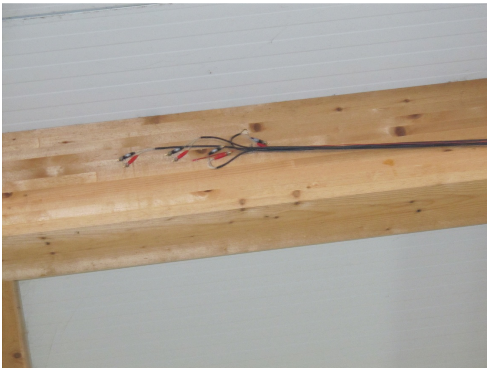
Abbildung F2-4: Ansicht Messstelle 2
