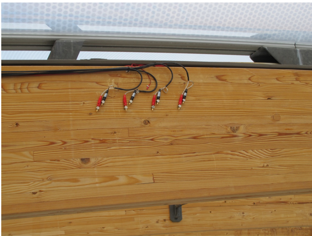
Abbildung A3-4: Ansicht Messstelle 2
