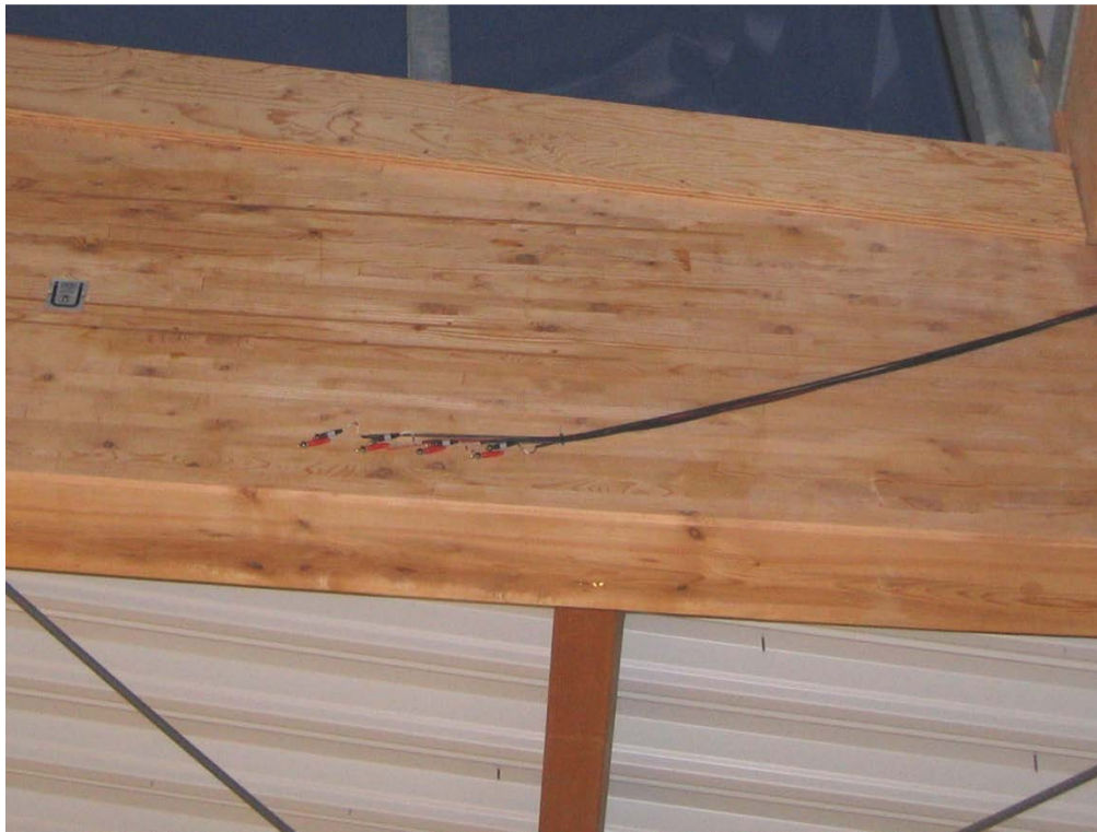
Abbildung D2-3: Ansicht Messstelle 1
