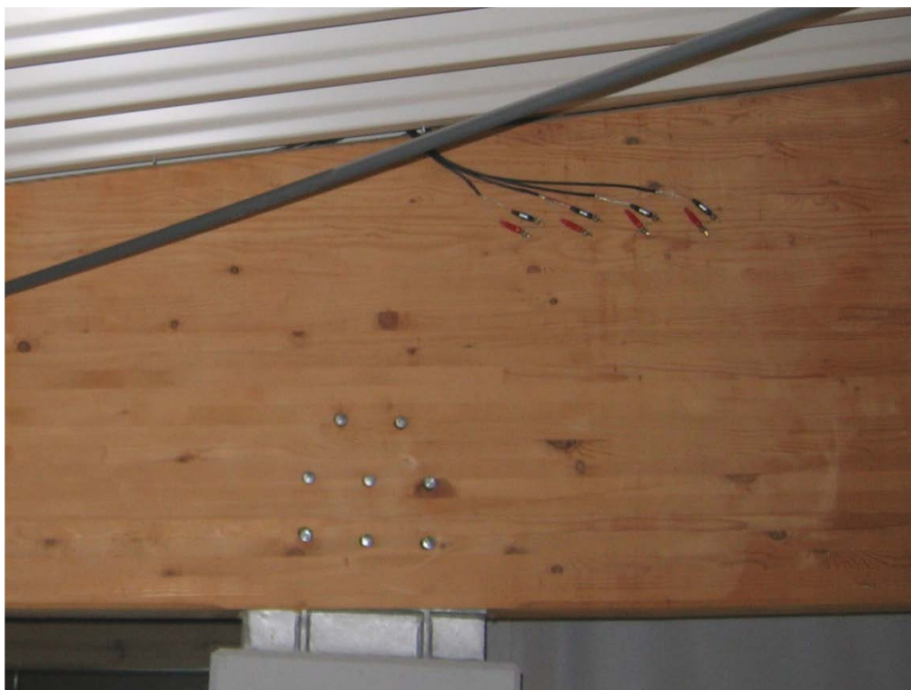
Abbildung D2-4: Ansicht Messstelle 2
