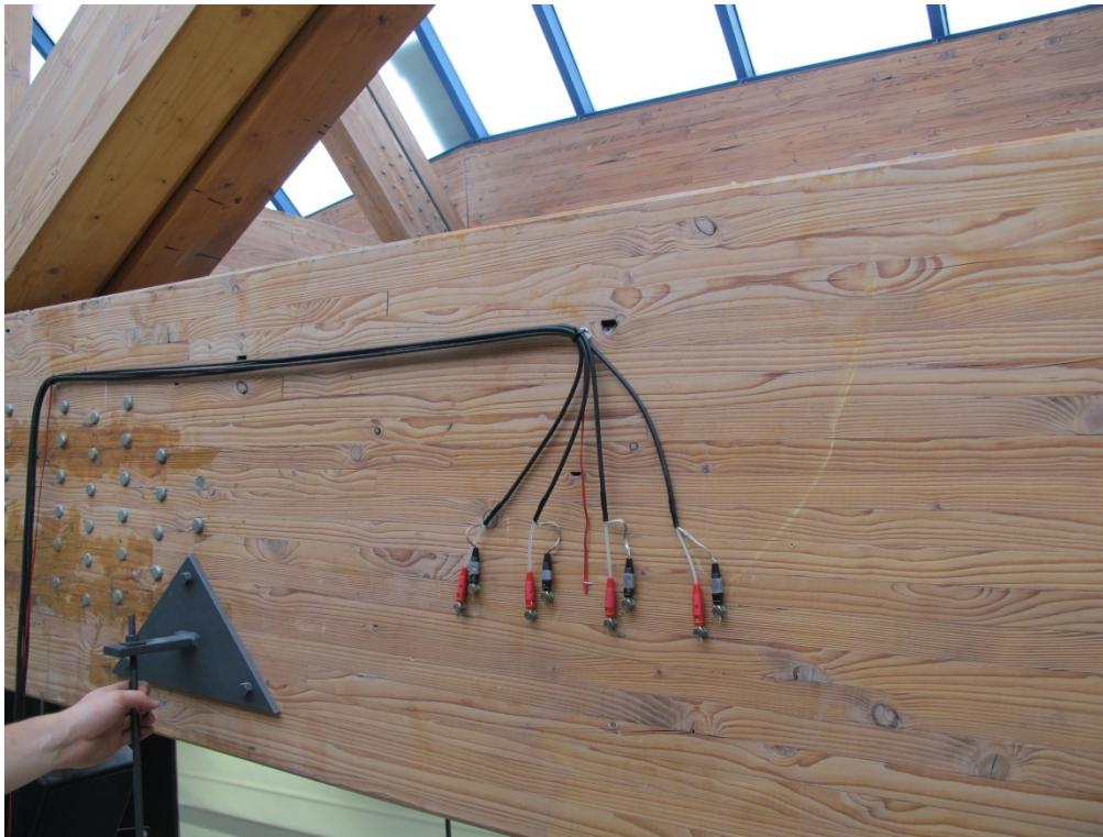
Abbildung D1-3: Ansicht Messstelle 1
