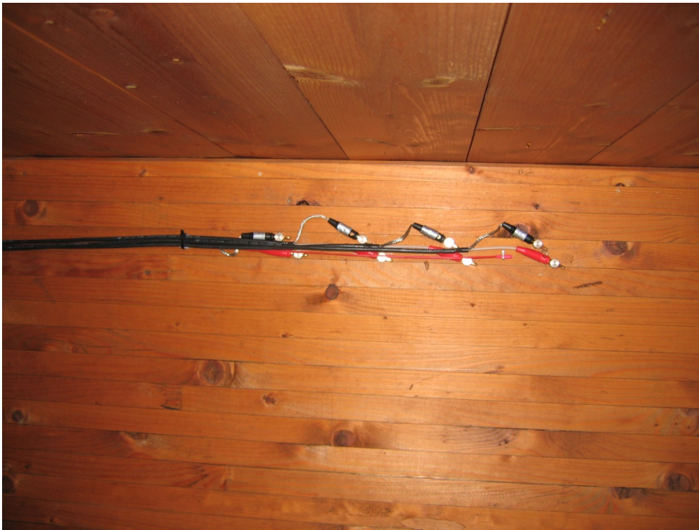
Abbildung B3-3: Ansicht Messstelle 1
