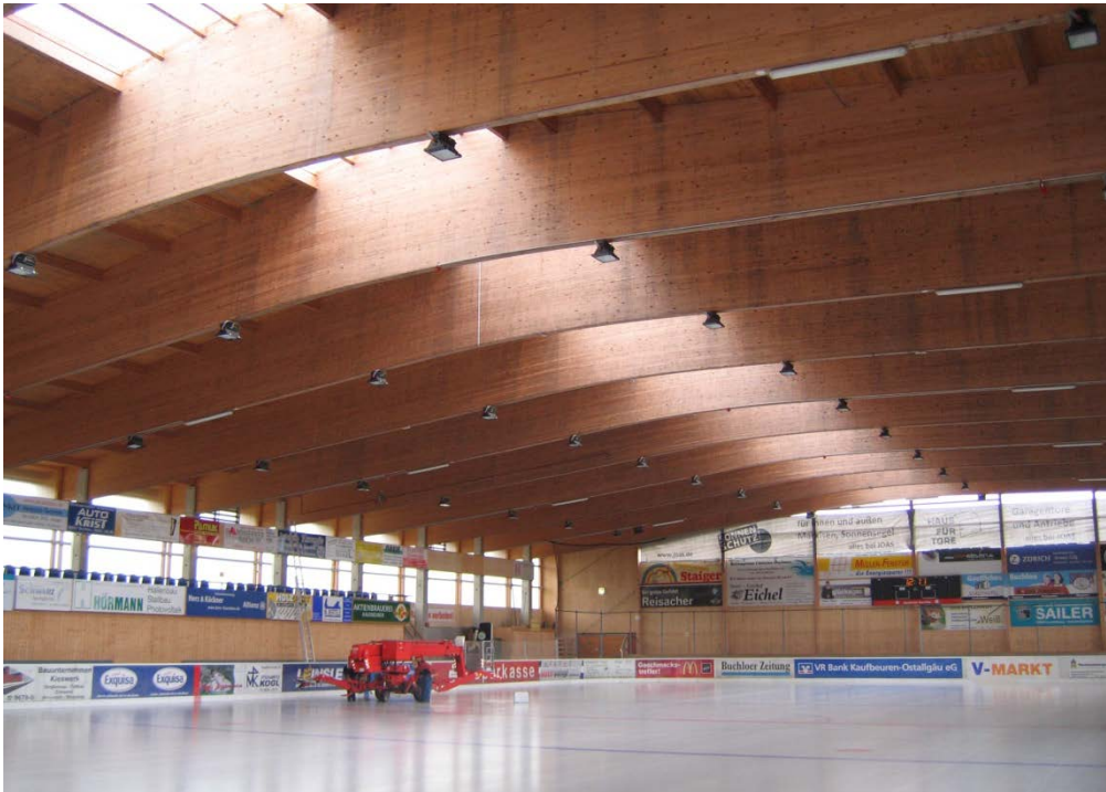
Abbildung B2-1: Ansicht Tragwerk
