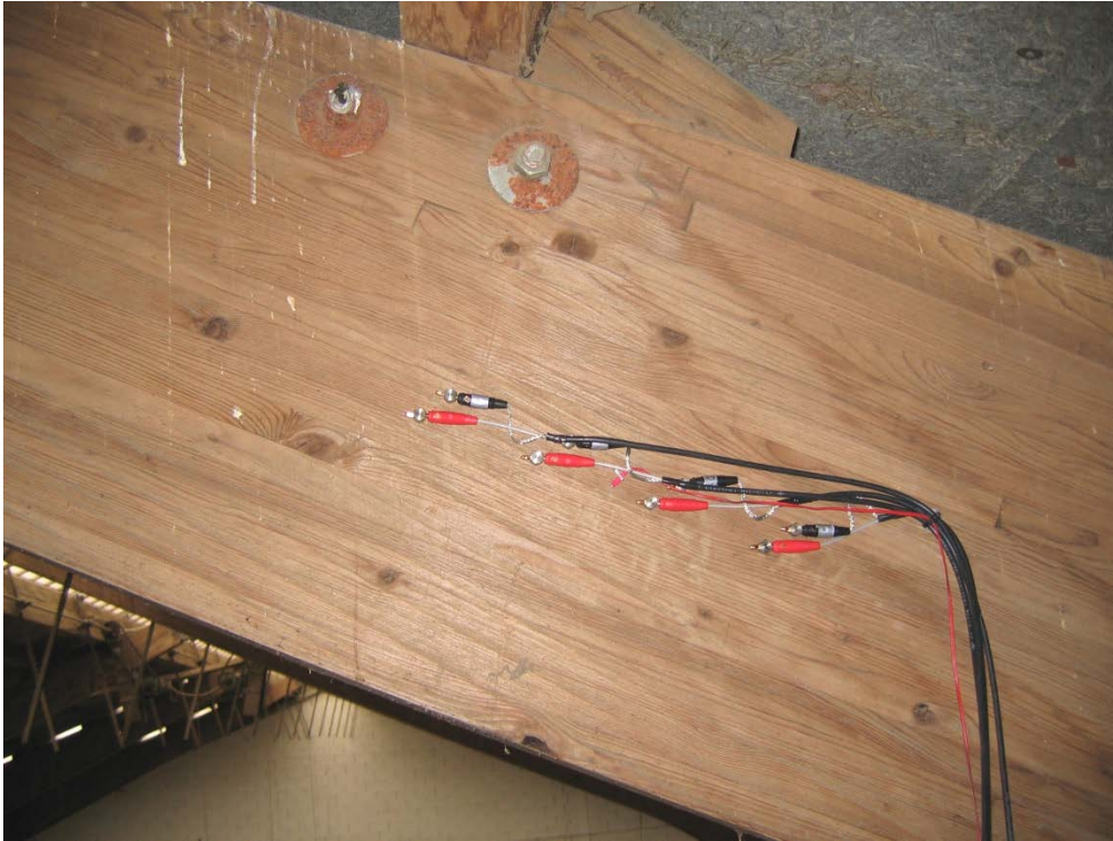
Abbildung F3-3: Ansicht Messstelle 1
