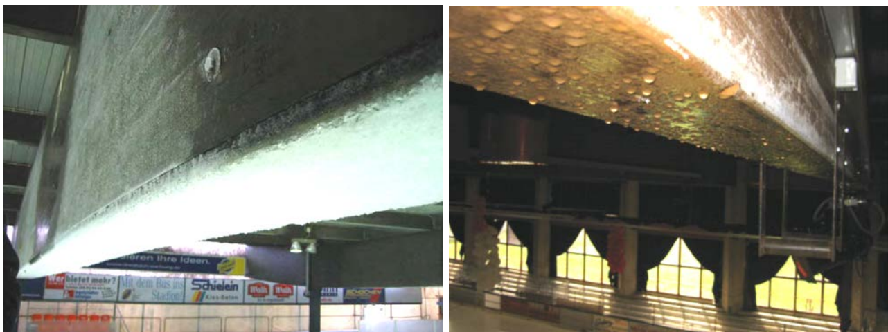
Abbildung 12 links: Eisbildung am Untergurt oberhalb der Eisfläche. Aus (Winter, 2007). Rechts: Tropfenbildung auf Unterseite eines Binders. Aus (Güldenpfennig, Vogelsberg & Stamminger, 2010).
