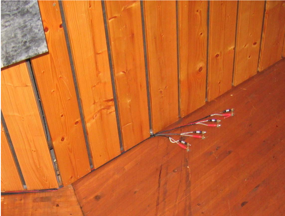
Abbildung A1-3: Ansicht Messstelle 1
