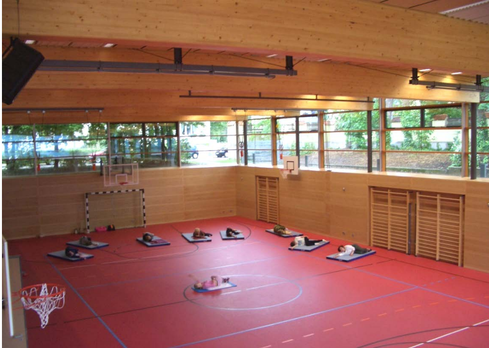
Abbildung D3-1: Ansicht Tragwerk
