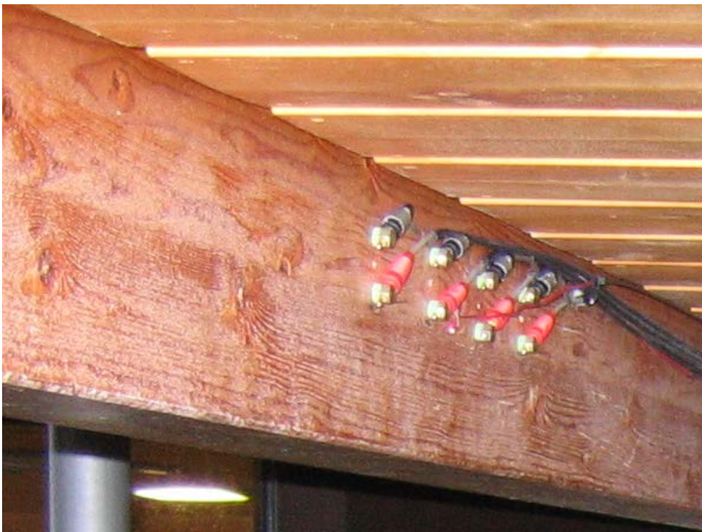
Abbildung A2-4: Ansicht Messstelle 2
