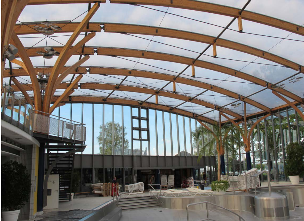
Abbildung A3-1: Ansicht Tragwerk
