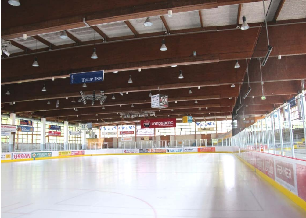
Abbildung B1-1: Ansicht Tragwerk
