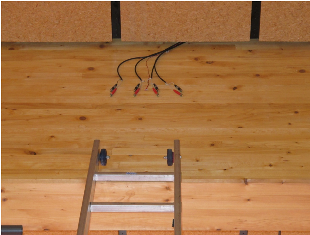
Abbildung D3-3: Ansicht Messstelle 1
