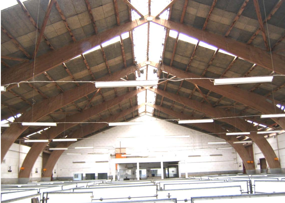
Abbildung F3-1: Ansicht Tragwerk
