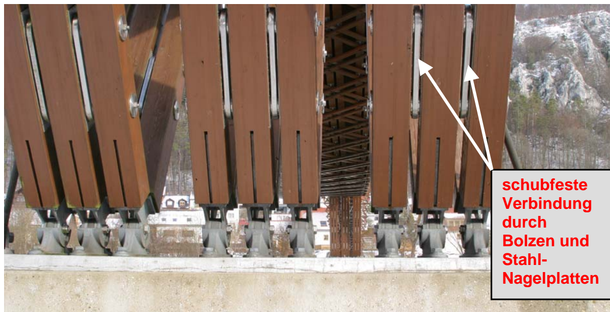
Abb. 3: Knotenpunkt: Verbindung zwischen Betonfundamenten und Stielen der Pfeilerkonstruktion.
