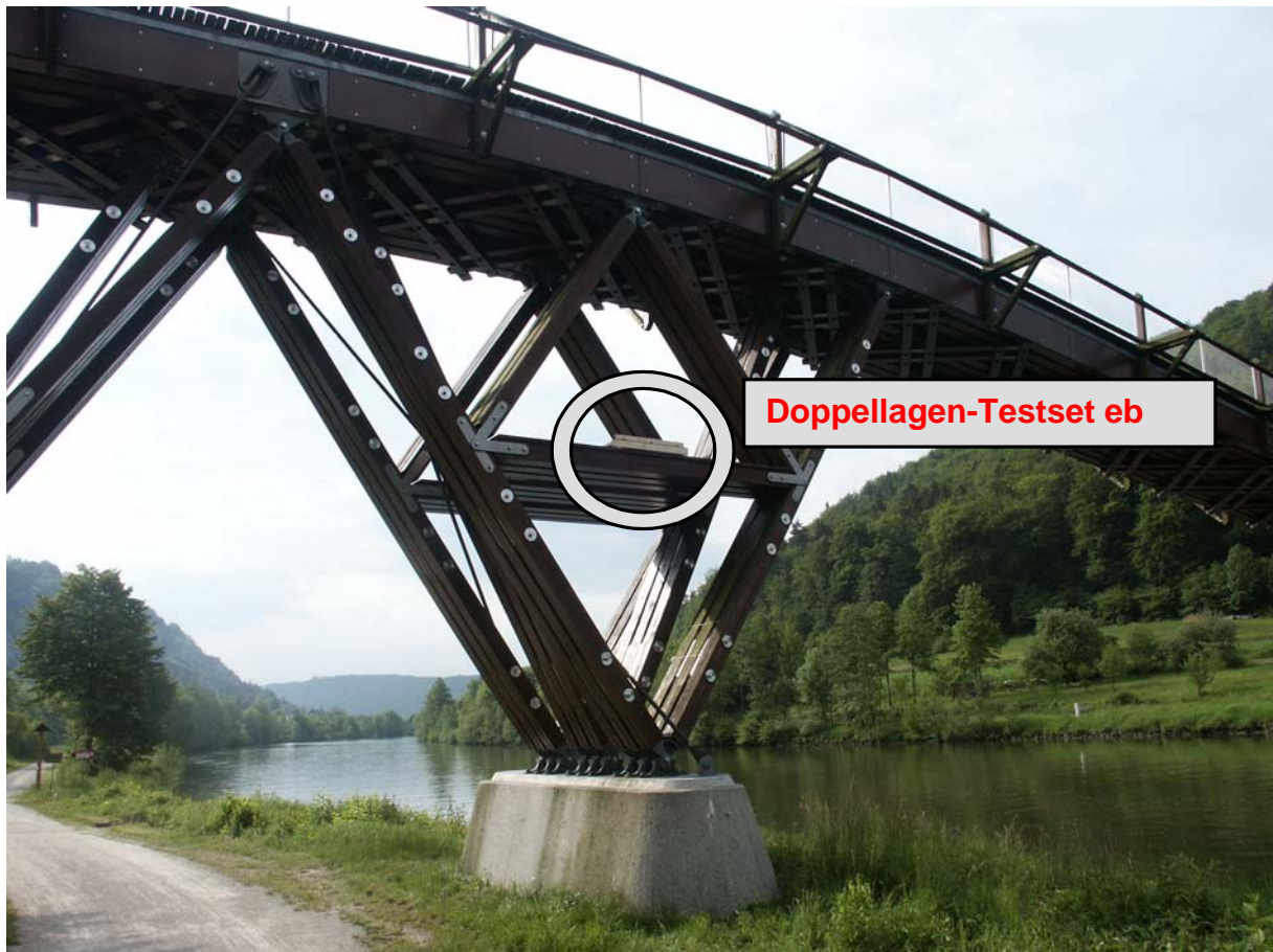
Abb. 12: Doppellagen-Testset eb ( essingbrücke ) exponiert auf den Querstreben (Wetterseite) von Pfeiler 2 der Essinger Brücke.
