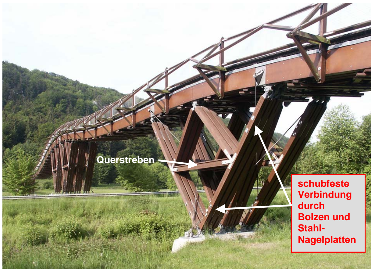
Abb. 2: Vertikale Abstützung durch V-förmige Pfeilerkonstruktion der BSH-Hauptträger zwischen Hauptstraße und Dorf Essing.
