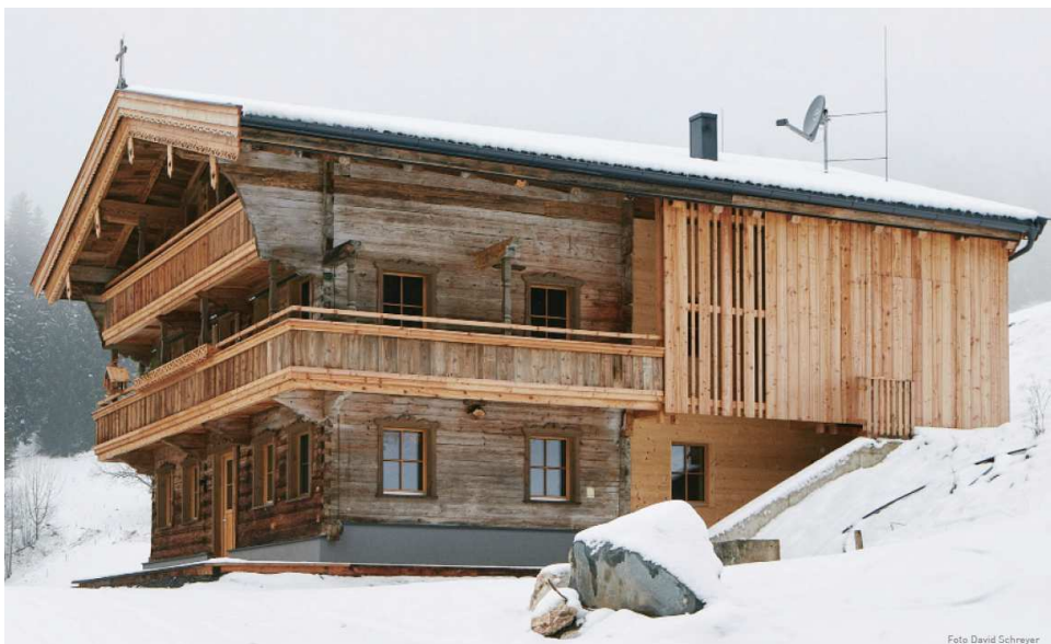
Abbildung 32: Südostansicht Hof „Neuhäusl“ (Foto: Schreyer David)
