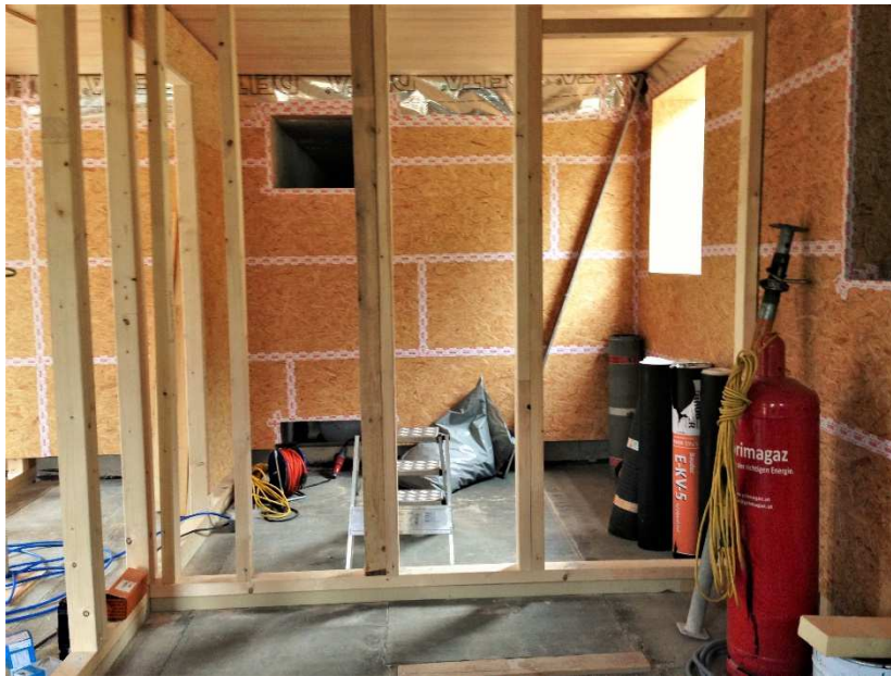
Abbildung 44: Ständerwerk der Innenwände, die luftdichte Ebene (OSB-Platte) bleibt durchgehend erhalten (Foto: DI Hans Peter Gruber)
