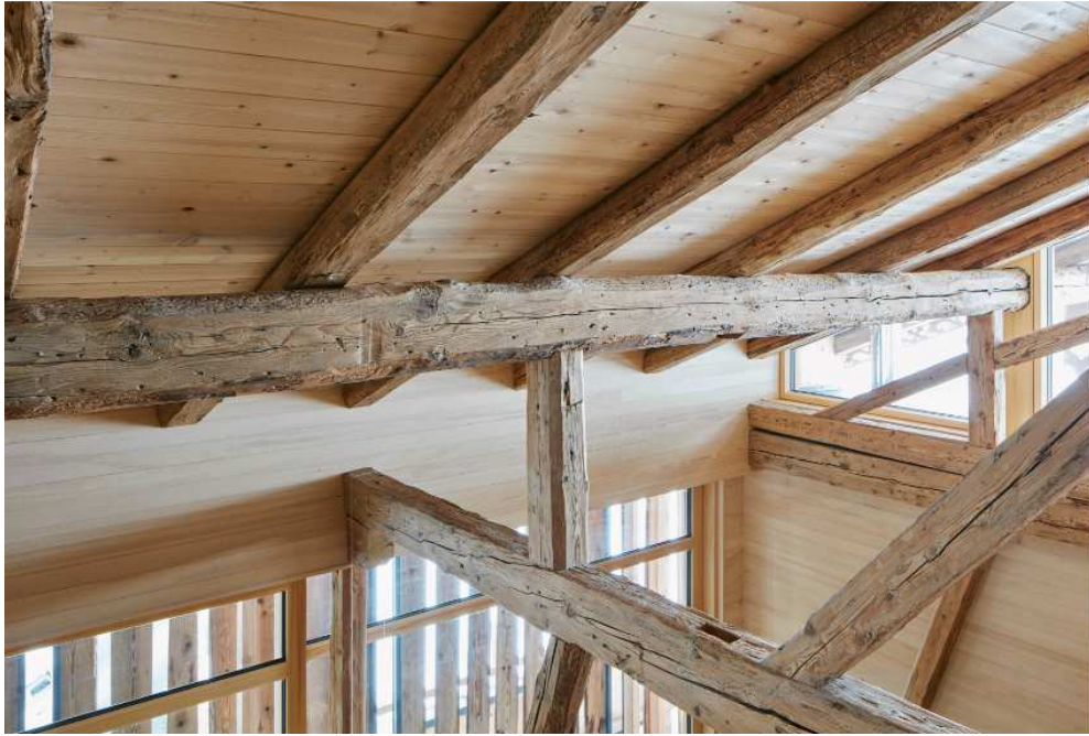
Abbildung 33: Alte Tragstruktur im hinteren Bereich (Foto: Schreyer David)
