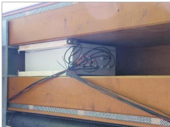
Installationskasten verschlossen
